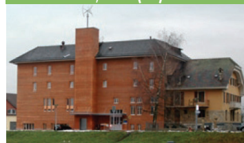
Bâtiment administratif, Yverdon (VD)
