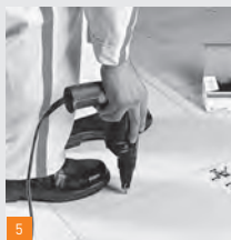
5 Vissage de la languette...
