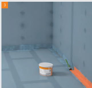
Appliquer la Sous-couche de protection à l'eau fermacell dans les angles.
