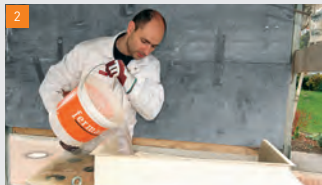
2 Ajouter 8 à 10 litres d'eau par sac
