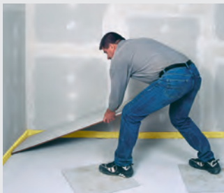
Pose des Plaques de sol
