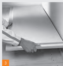
3 Pose de la première dalle
