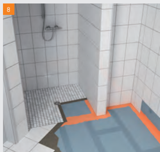
Si vous intégrez des Plaques Powerpanel dans une douche à l'italienne, vous devez également isoler la jointure entre la douche et le plancher contre l'humidité.
