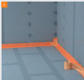
Appliquer le ruban isolant fermacell sur l'Etanchéité fermacell avant qu'il ne sèche.
