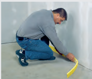
Pose des bandes d'isolation latérales
