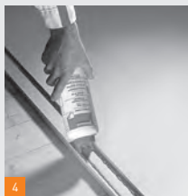
4 Application de la colle
