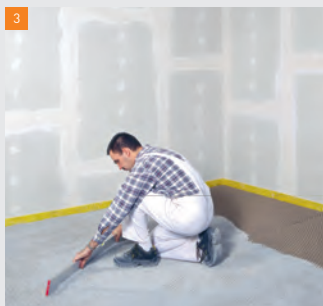
Aplanir les granules pour nid-d'abeilles fermacell
